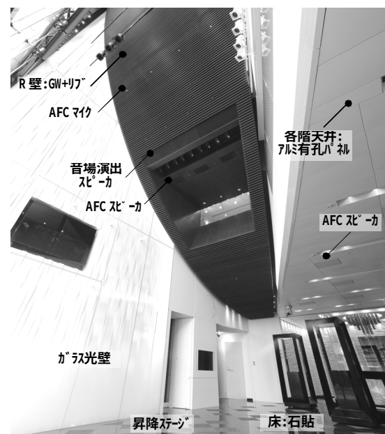
図3 ポータル音響設計概要
