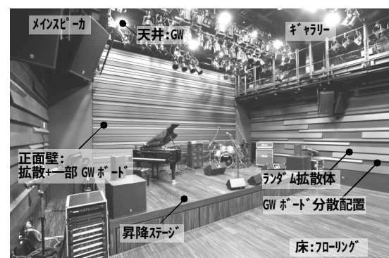
図4 スタジオ音響設計概要
